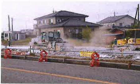
生石灰粉状品による施工状況
