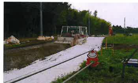
ドライムソフトによる施工状況
