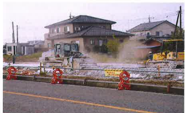
生石灰粉状品による施工状況
