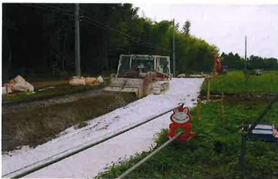
ドライムソフトによる施工状況
