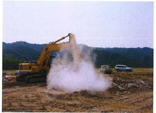
生石灰粉状品(一般品)による混合状況
