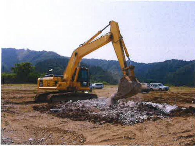
ドライムソフトによる混合状況
